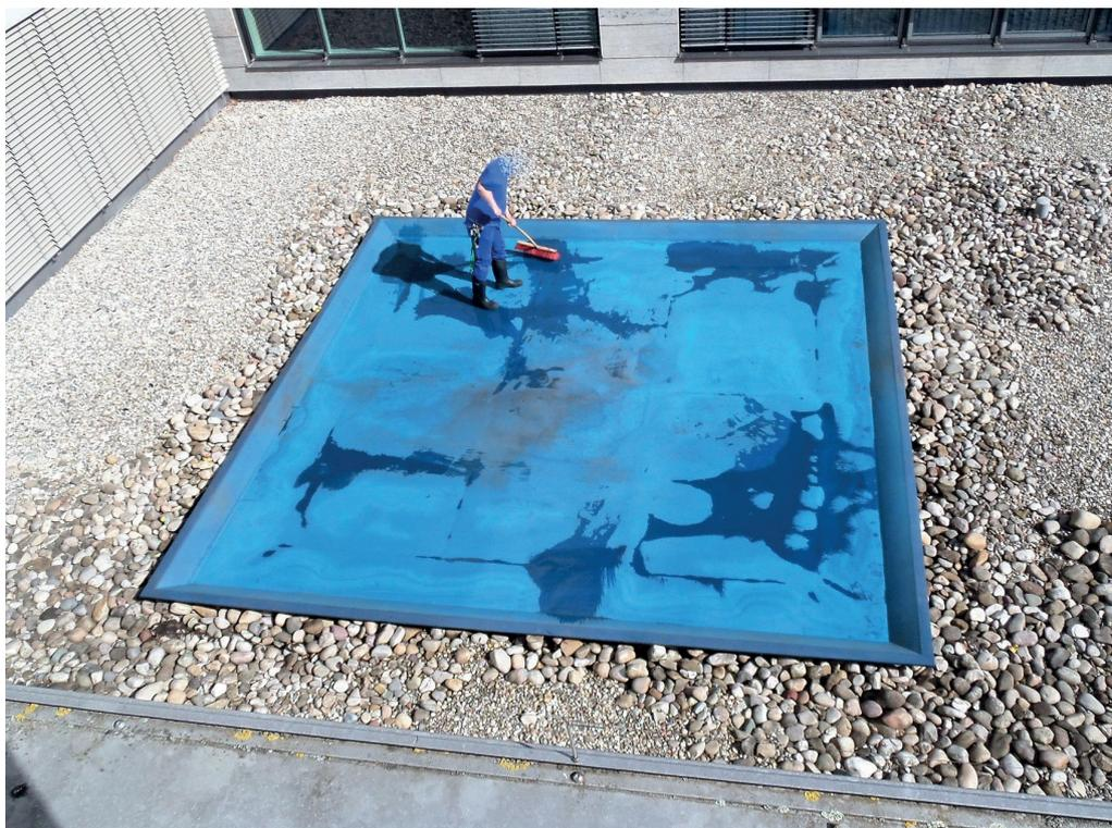
Das als tiefblaues Wasserbecken gestaltete Kunstwerk wurde kurz nach Fertigstellung undicht und daraufhin trocken-gelegt. Darunter befindet sich der OP-Bereich des Klinikums (Universitätsklinikum Würzburg, Operatives Zentrum).
